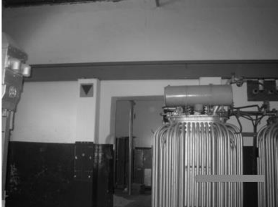
Fig. VII.50 Imagen de la vista interior oeste de la planta de San Simonito en la cual se aprecia el muro divisorio de las dos naves y las características arquitectónicas que presenta. Fotografió Eduardo López Cruz (07/12/2007).
