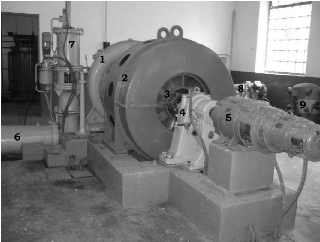
Fig. VI.26 Esta imagen muestra las partes del generador los cuales son los siguientes: 1.- muestra la carcasa y en el interior se localiza la turbina es de tipo Francis, 2.- Es la carcasa del generador, 3.- Es el difusor de calor del generador, 4.- La carcasa de los baleros de la flecha, 5.- Es el excitador del generador, 6.- Toma de agua del generador, 7.- Regulador de presión de agua, 8-9.- Distribuidor de aceite a presión. Fotografíó Javier Campos Garduño (07/12/2007).
