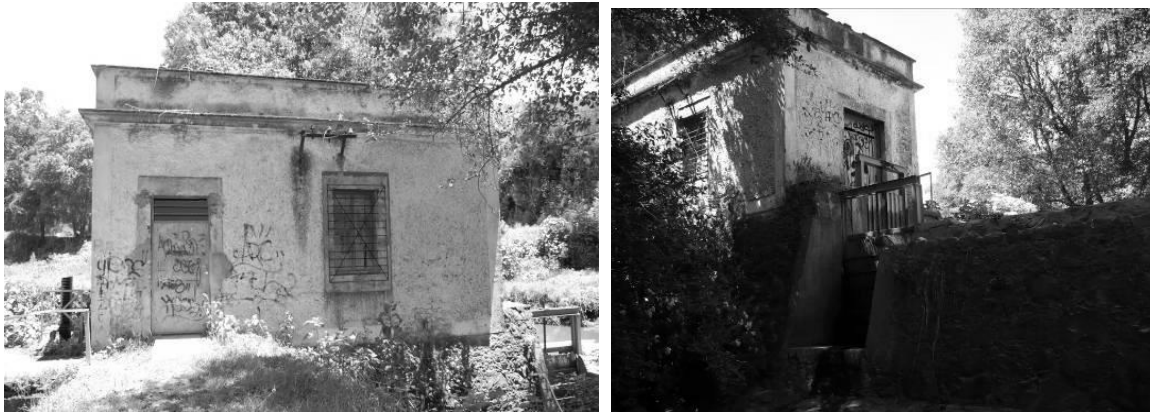
Fig. VII.5 a) Imagen de la vista exterior suroeste del cuarto de operación de la presa de San Simonito b) Vista exterior oeste del cuarto de operación de la presa de San Simonito. Fotografió Eduardo López Cruz (07/12/2007).
