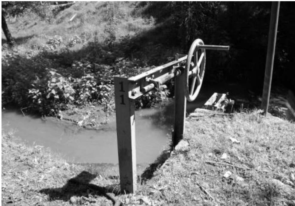
Fig. VI.5 Imagen que muestra las características de la compuerta número once ubicada en la presa Zepayautla, este tipo de compuertas es igual que las localizas en la presa Zictepec. Fotografió Javier Campos Garduño (07/12/2007).
