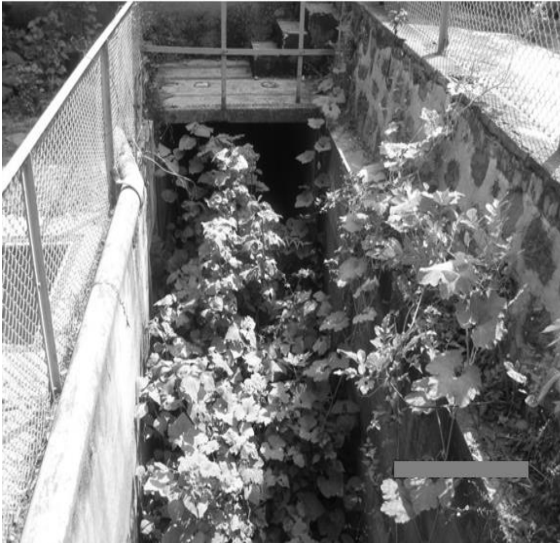
Fig. VII.60, Imagen que muestra la salida del desagüe de los generadores además de sus características constructivas. Fotografió Eduardo López Cruz (19/06/2010).
