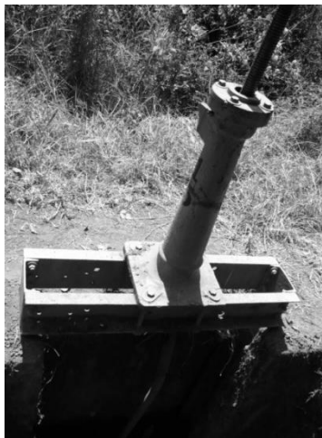
Fig. VI.7 Imagen que muestra los elementos que conforman la compuerta número quince. Fotografíó Javier Campos Garduño (07/12/2007).
