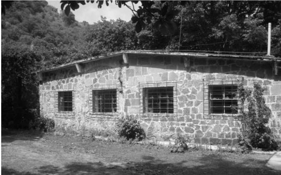
Fig. VII.31 Imagen de la fachada este del campamento de ingenieros, muestra los elementos arquitectónicos. Fotografió Eduardo López Cruz (07/12/2007).
