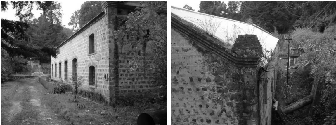
Figs. VI.22 a-b. Imagen que muestra la vista exterior noroeste de la planta de Zepayautla donde se aprecia sus características arquitectónicas. Fotografíó Javier Campos Garduño y Hugo Javier Velásquez Tolentino (07/12/2007).
