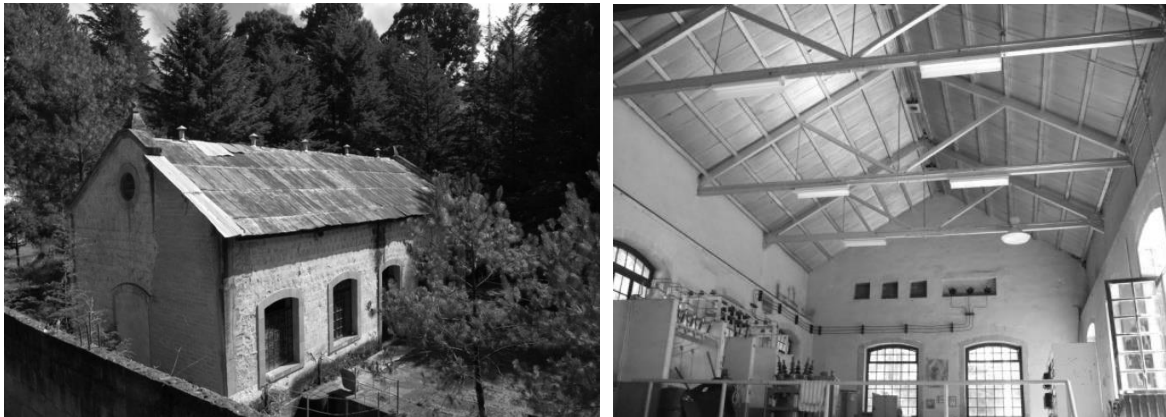
Figs. V. 29 a) Imagen de la vista exterior sur poniente de la planta de Zictepec b) Imagen de la vista interior norte de la planta donde aprecia las características del techo y la maquinaria. Fotografíó Javier Campos Garduño y Eduardo López Cruz (07/12/2007).
