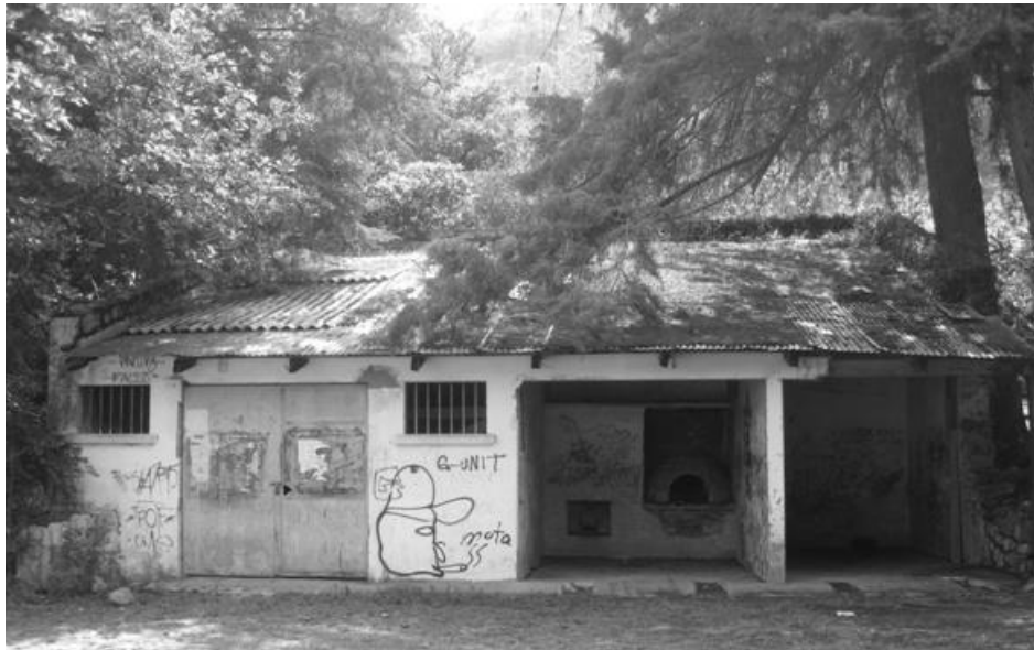
Fig. VII.32 Imagen que muestra la nomenclatura para identificación de las aéreas del complejo de las caballerizas. Dibujo Eduardo López Cruz. Fig. VII.33 Imagen del área de las caballerizas se observa el muro oeste y el techo de lámina con los soportes de madera. Fotografió Eduardo López Cruz (07/12/2007).
