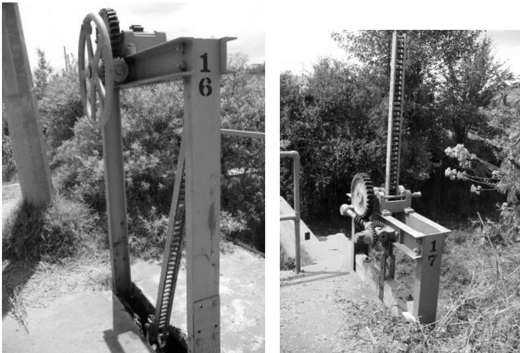
Fig. VI.14 Imagen de las características de la compuerta número 16 ubicada en la cámara de presión de Zepayautla, este tipo de compuertas es igual que las localizas en la presa Zictepec y presa Zepayautla. Fotografió Javier Campos Garduño (07/12/2007). Fig. VI.15 Imagen de las características de la compuerta número 17 ubicada en la cámara de presión de Zepayautla, este tipo de compuertas es similar que las localizas en la presa Zictepec y presa Zepayautla. Fotografió Javier Campos Garduño (07/12/2007).
