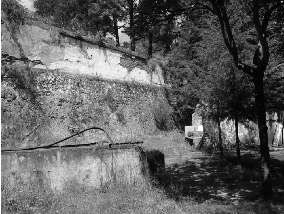
Fig. V.23 Imagen que muestra las características de la barda de adobe y el desplante de mampostería de la hidroeléctrica de Zictepec. Fotografió por Javier Campos Garduño (07/12/2007).
