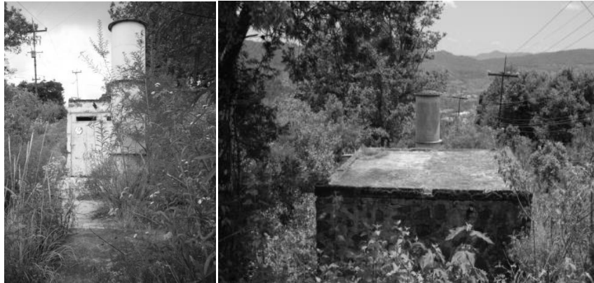
Fig. VII.22 En esta imagen se muestran la parte frontal del cuarto de válvulas y la chimenea del salto de agua. Fig. VII.23 En esta imagen se muestran el muro norte y el techo del cuarto de válvulas y la chimenea del salto de agua. Fotografió Eduardo López Cruz (07/12/2007).
