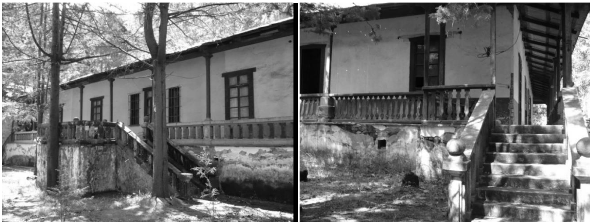
Fig. V.26-27 Imágenes de las fachadas Sur y Oeste del campamento de ingenieros, muestra los elementos arquitectónicos. Fotografió Javier Campos Garduño y Eduardo López Cruz (07/12/2007).
