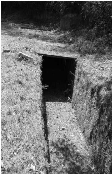
Fig. VII.12 En esta imagen se muestra la construcción del canal de concreto y sus tapas, Fig. VII.13. En esta imagen se muestran los tipos de canales del circuito San Simonito. Dibujó y Fotografíó Eduardo López Cruz (07/12/2007).
