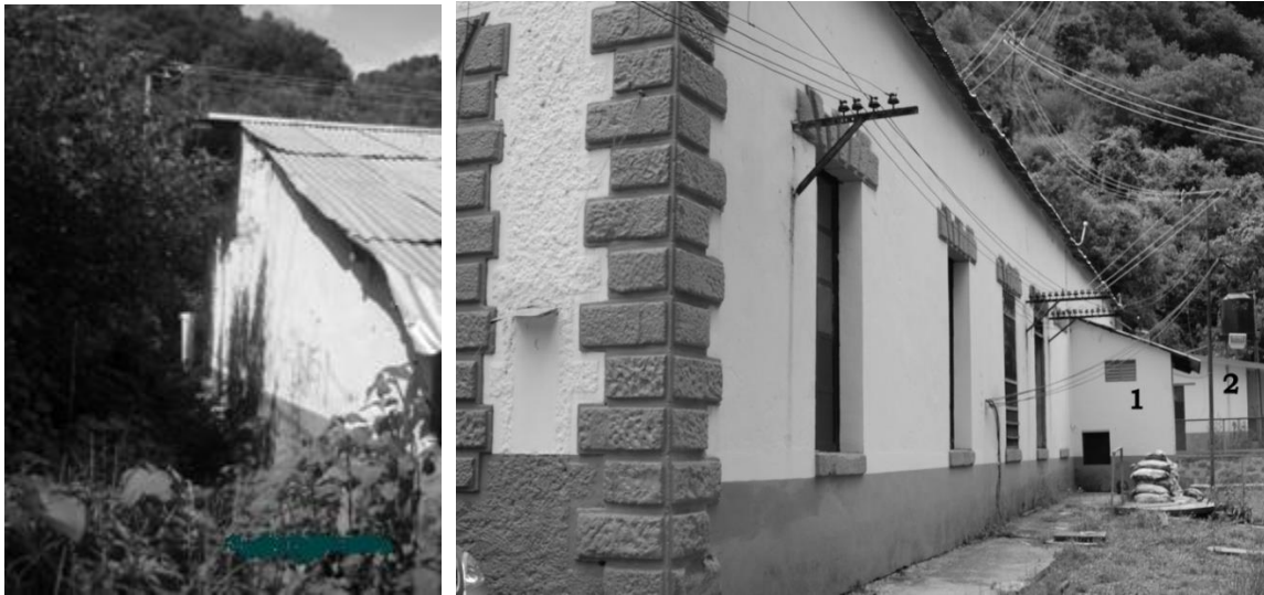
Fig. VII.44 Imagen de la vista exterior del muro norte de la planta de San Simonito donde aprecia las características y elementos arquitectónicos. Fig. VII.45 Imagen de la vista exterior del muro oeste de la planta de San Simonito donde aprecia las características y elementos arquitectónicos, la nomenclatura se colocó para identificar los cuartos adosados al muro y son; 1.- la bomba y 2.- el baño. Fotografíó Eduardo López Cruz (07/12/2007).
