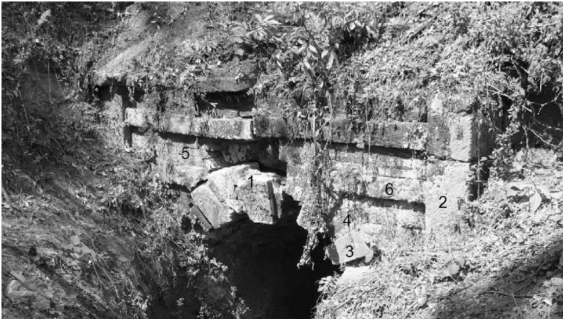
Fig. V.15 Imagen en la que se observa arquitectura de la salida del túnel, clave (1), pilastra (2), dovelas (3-6), imposta (4), riñón o pared (5). Fotografíó Javier Campos Garduño (07/12/2007).
