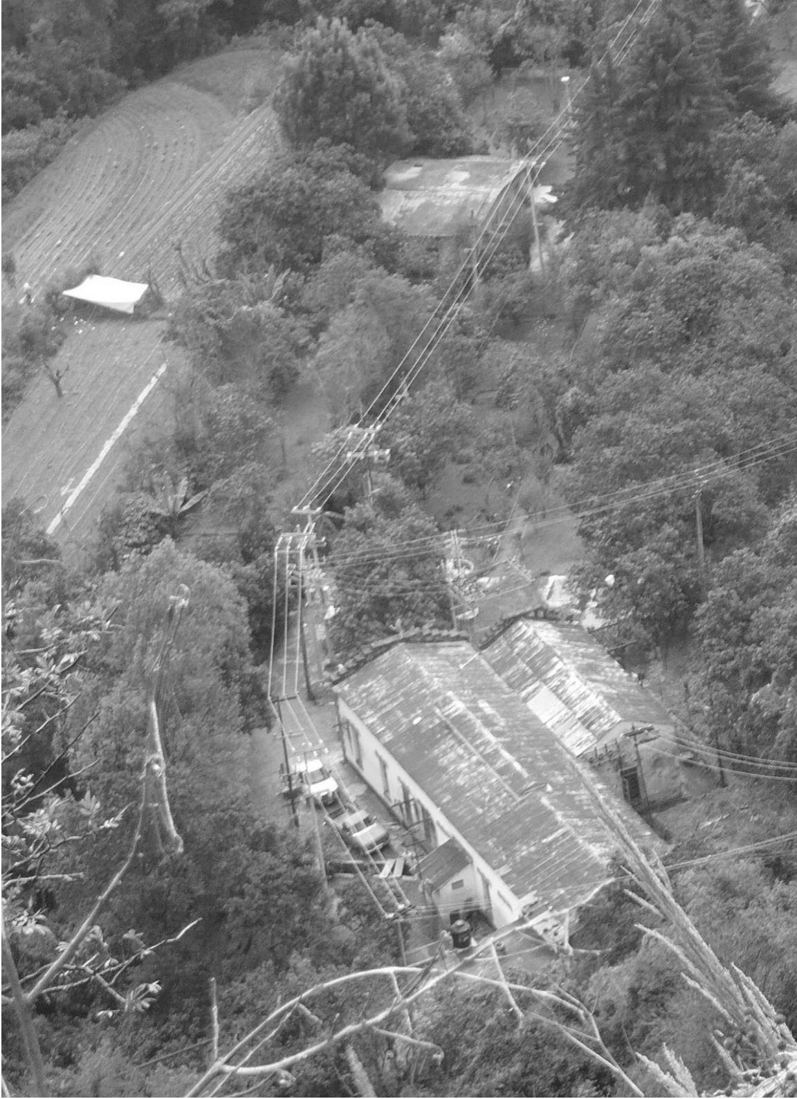
Vista panorámica de la Planta San Simonito. 2009
