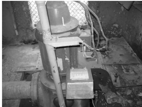
Fig. VII.46 a. Imagen que muestra el plano de la bomba de agua instalada en el desagüe del generador uno de la planta de San Simonito. Dibujo Eduardo López Cruz (07/12/2007).
