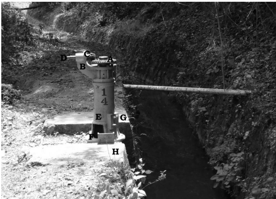
Fig. VI.6 Imagen que señala las características de la compuerta número catorce, este tipo de compuerta es diferente a las anteriores los elementos que presenta son los siguientes; A.- engrane vertical. B.- brazo, C.- engrane horizontal, D.- eje, E.- soporte, o tubo semiconico, F.- retenida de la compuerta, barra circular con cuerda tipo macho y F-G.- muretes y soportes de la compuerta. Fotografíó Hugo Javier Velásquez Tolentino (07/12/2007).
