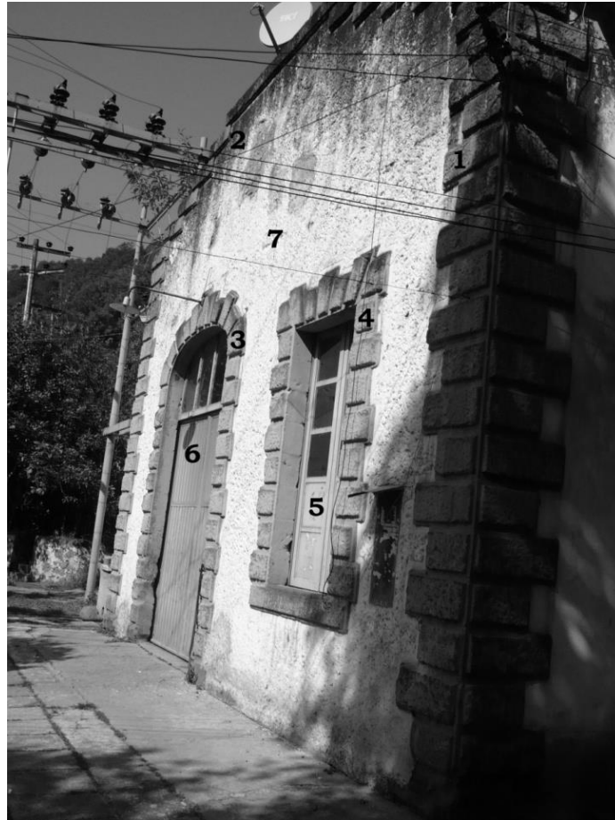
Fig. VII.42 Imagen de la vista exterior sur del muro de la planta de San Simonito donde se aprecia sus características arquitectónicas en la cual usamos una nomenclatura para identificar sus elementos que la integran; 1.- arístón, 2.- remate piramidal falso con almohadillado, 3.- vano del acceso de tipo car panel, 4.- vano de la ventana tipo planta banda, 5.- ventana de madera, 6.- puerta metálica, 7.- acabado aplanado. Fotografió Eduardo López Cruz (07/12/2007).
