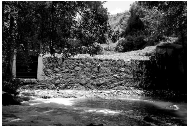
Fig. VII.2 Imagen de las características de la presa y las compuertas número 22 y 23 ubicada en la presa de San Simonito. Fotografió Eduardo López Cruz (07/12/2007).
