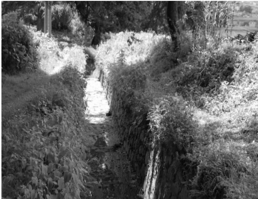
Fig. VII.11 En estas dos imágenes se muestran las dos formas de construcción de los canales, además de que se observa la arquitectura y los elementos constructivos del mismo. Fotografíó Eduardo López Cruz (07/12/2007).
