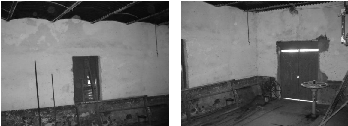
Fig. VII.6 (a-b) Imagen de la vista del interior del cuarto en el que se observa el tipo de techo y de la compuerta. Fotografíó Eduardo López Cruz (07/12/2007).
