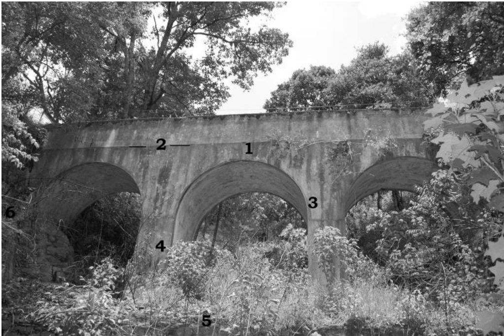
Fig. VII.17 En esta imagen se muestra la clave de cantera en forma rectangular y tiene grabado lo siguiente “1905 R.J.M.D. E.O.G.”. Fig. VII.18 En esta imagen se muestra la estructura del acueducto y sus elementos que lo integran. Fotografíó Eduardo López Cruz (07/12/2007).
