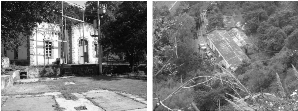
Figs. 40 y 41 la Imagen 40 es la vista exterior sureste de la planta de San Simonito, y la 41 es la vista exterior del techo en el cual se aprecian sus características constructivas. Fotografió Eduardo López Cruz (07/12/2007).
