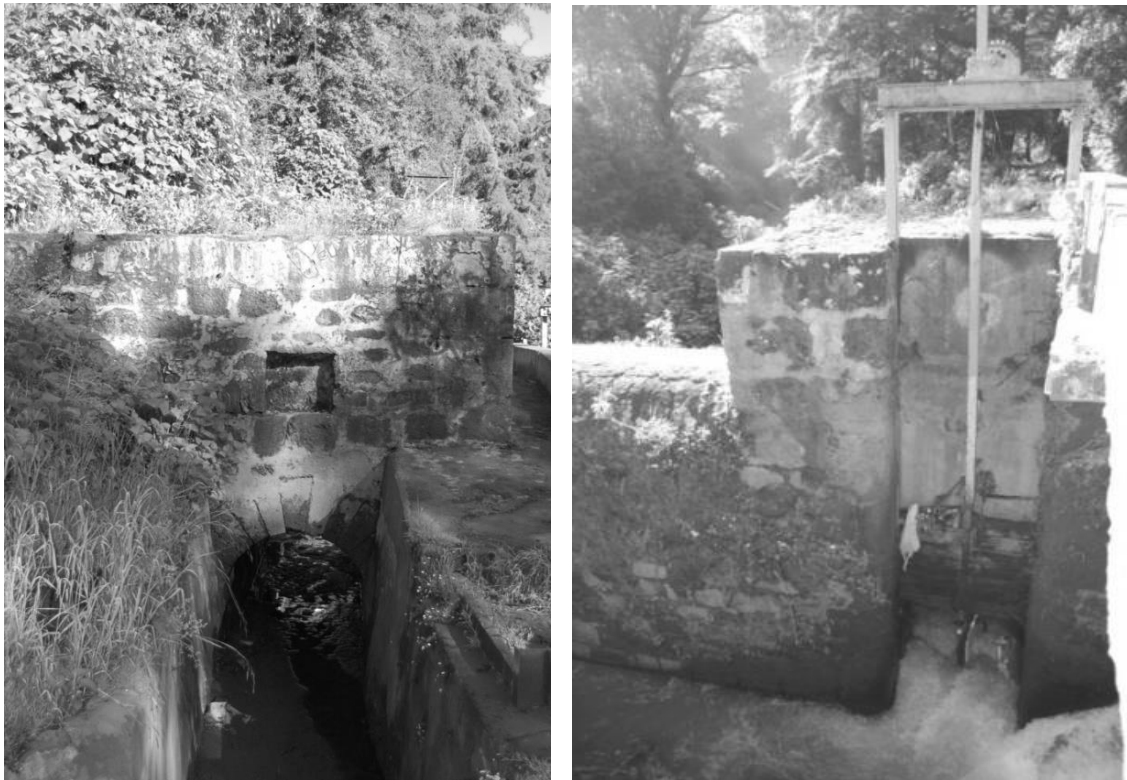
Fig. V.9 En esta imagen se muestra la arquitectura del canal, el pequeño túnel, los cuales son el soporte o plataforma de lo que era “el cuarto de tanquero” y del pequeño túnel de la presa Zictepec. Fig. 10. Imagen que muestra las características de la compuerta número siete ubicada en la presa Zictepec a diferencia de la primera compuerta es de que su cortina es de madera y el de la compuerta uno ubicada en los manantiales es de metal y más pequeña. Fotografió Javier Campos Garduño (04/08/2009).
