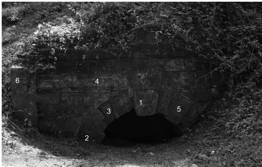
Fig. V.14 Imagen que presenta la arquitectura de la chimenea, para identificar los elementos arquitectónicos los enumeramos y son los siguientes: clave (1) , impostas (2 y 5) , estas son piezas de cantera las cuales sobresalen de las dovelas a las altura de la clave y también son elementos del arco de medio punto, dovelas (3) ; este tipo de dovela es diferente a la que encontramos en la entrada del túnel ya que este elemento no forma parte del arco pero se le conoce de este nombre por que funge como una crestería pero es dovela 137 , pilastra (6) , riñón o pared (4) . Fotografíó Javier Campos Garduño (07/12/2007).
