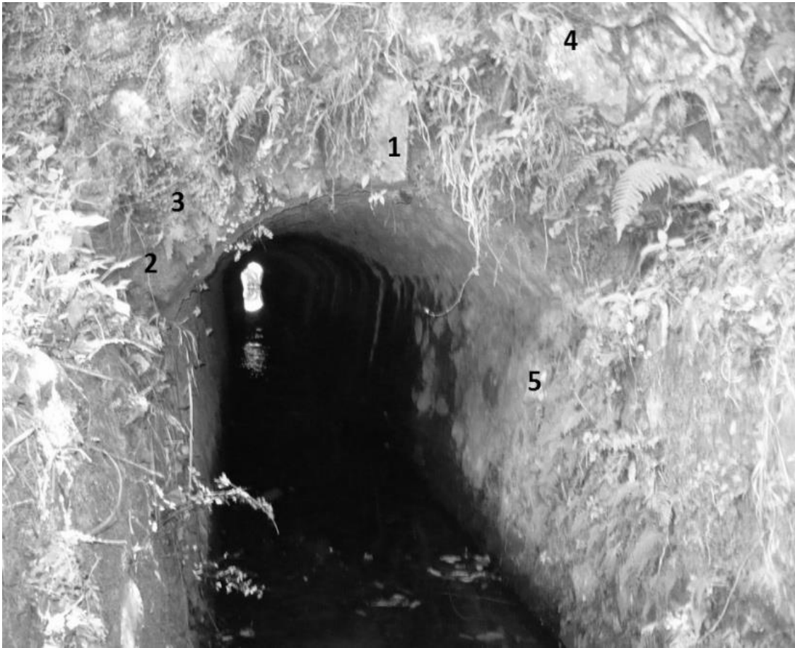
Fig. VI.9 Imagen que presenta la arquitectura de la salida del túnel, para identificar los elementos arquitectónicos los enumeramos y son los siguientes: clave (1), impostas (2), dovelas (3), riñón (4), soporte y pared del canal (5). Fotografió Javier Campos Garduño (07/12/2007).
