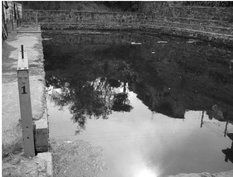
Fig. V.4 Imagen en la que muestra el manantial “la cruz” y muestra la distribución de sus elementos como lo son; las compuertas y su represa. Fotografió Javier Campos Garduño (07/12/2007).
