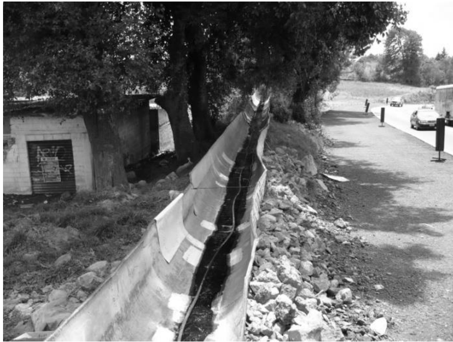
Fig. VI.12 En esta imagen se muestra la arquitectura y los elementos constructivos del canal de lámina. Fotografíó Javier Campos Garduño (07/12/2007).
